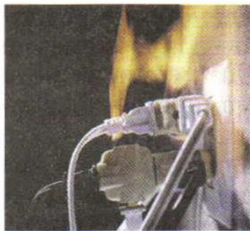
Рис. 89. Короткое замыкание в электропроводке
