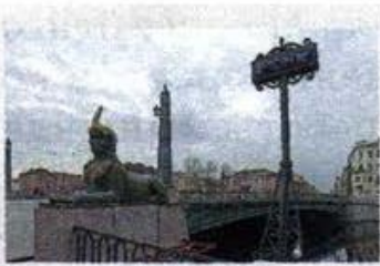
Египетский мост, построенный заново в 1954—1956 гг.
