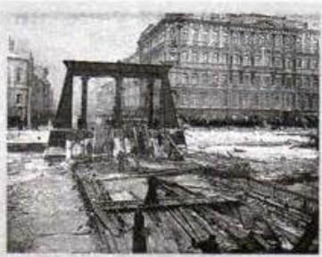
Разрушенный Египетский мост
